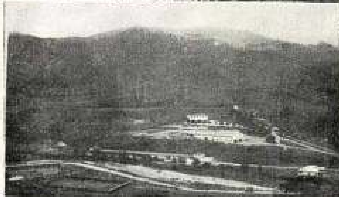
2º Panorámica de las edificaciones y terrenos.
